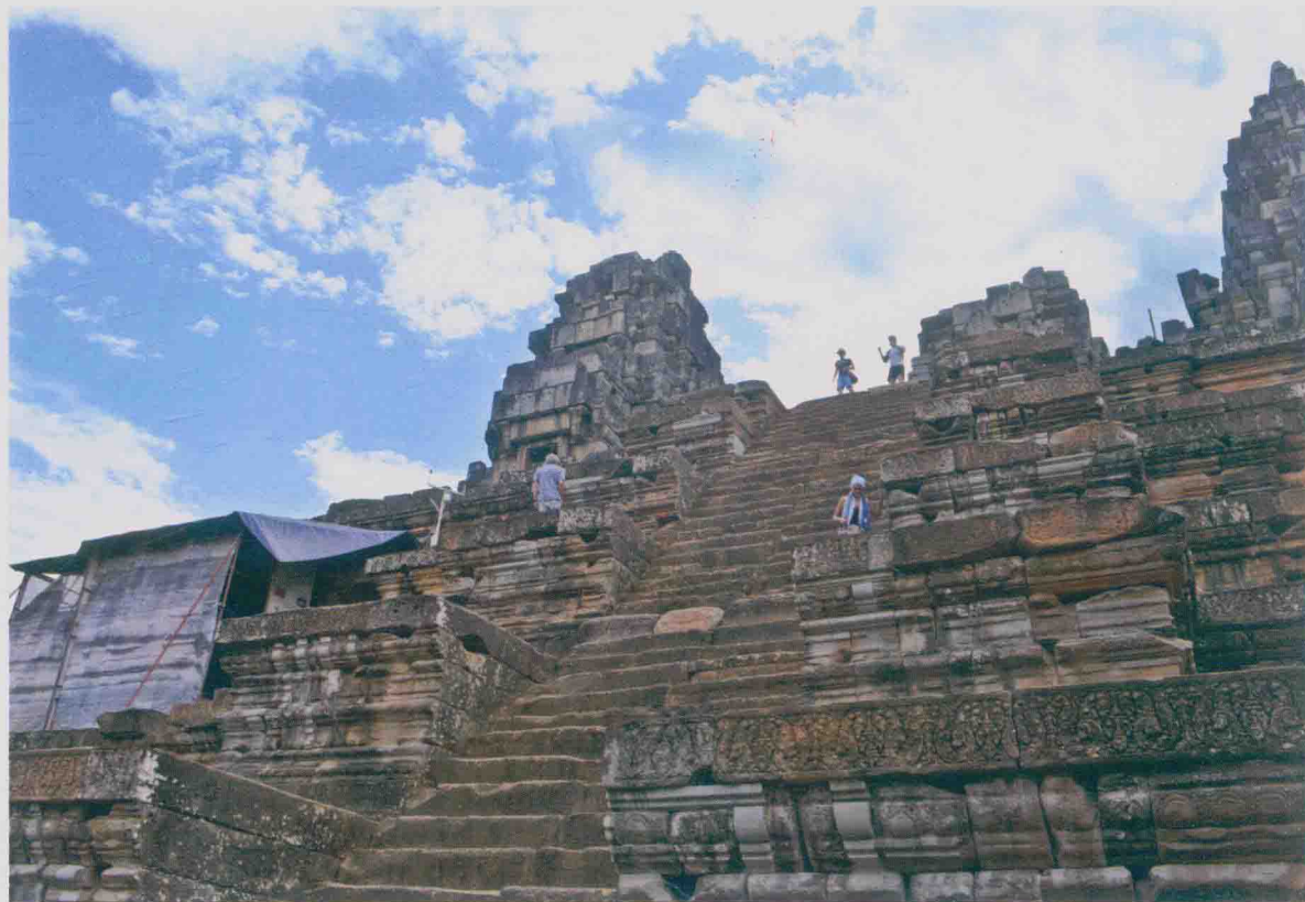
文物援外工程——柬埔寨茶胶寺须弥台东踏道修复现场
