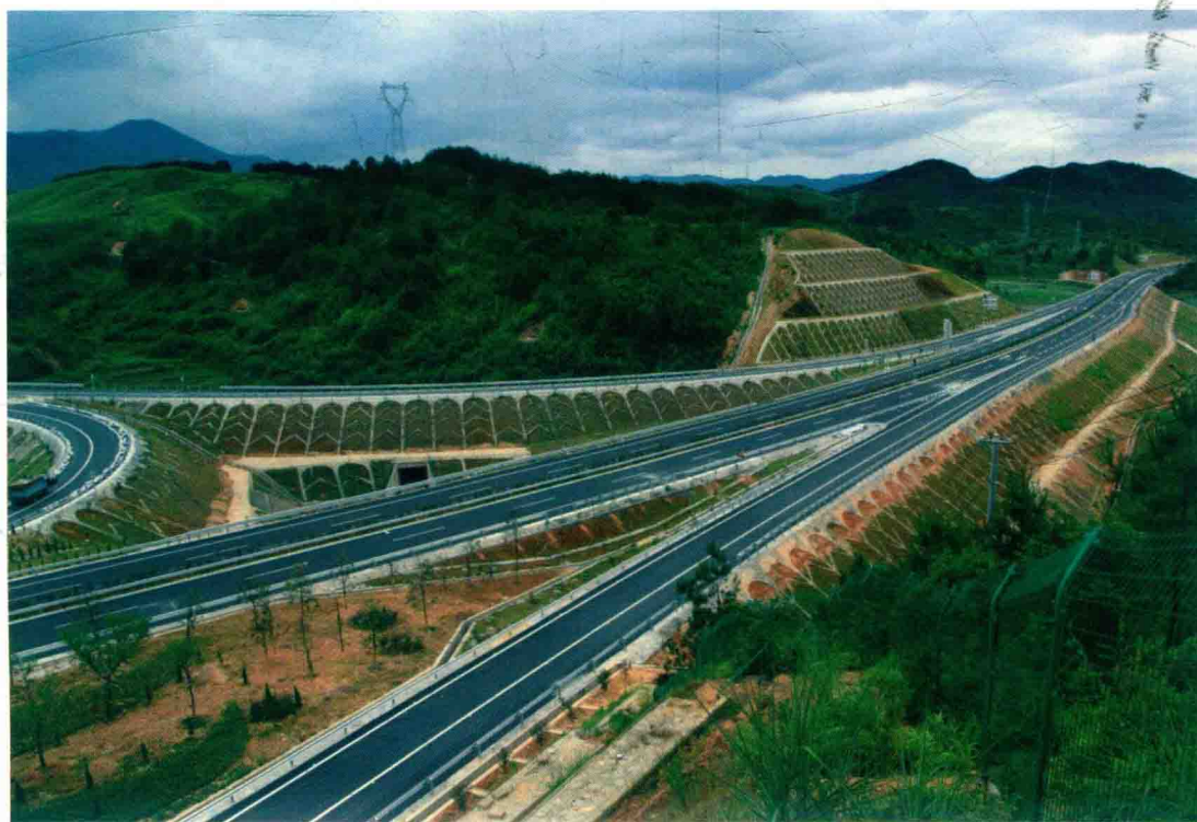
▲ 2012年6月30日，宁武高速（宁德段）建成通车，图为宁武高速屏南互通（宁德市政府办供稿）
