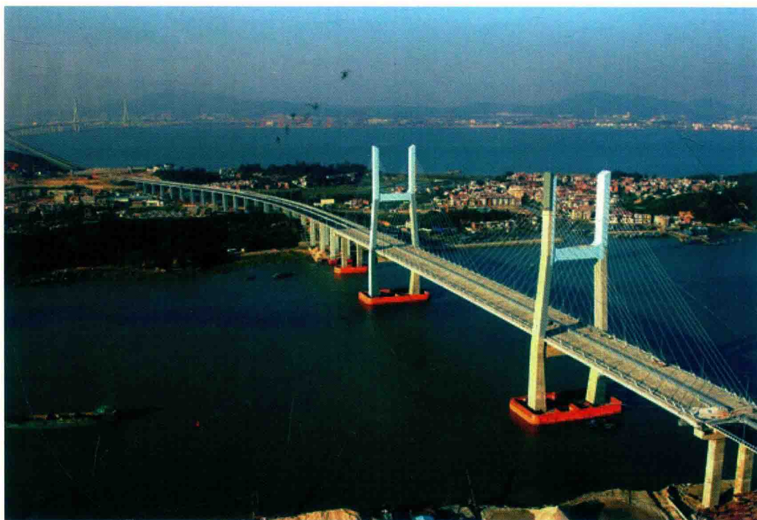
▲ 2012年12月21日，厦漳跨海大桥全线贯通
