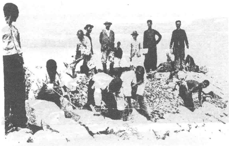
河南沁河口之乾砌石工
