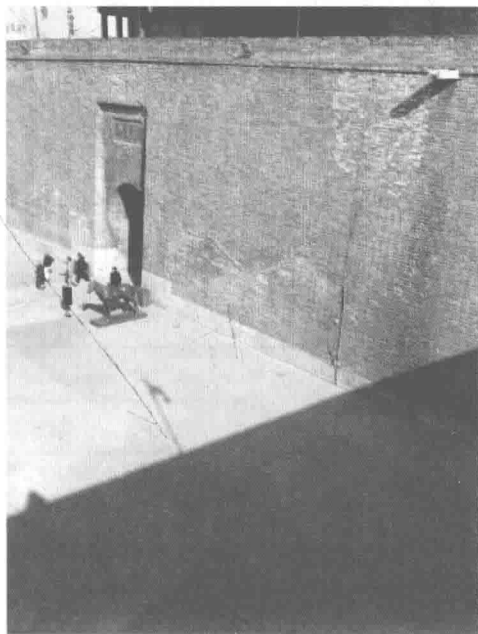
图 2.1 安定门城楼高台基西立面
