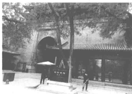
图 2.5 安定门城楼高台基东立面中间段
