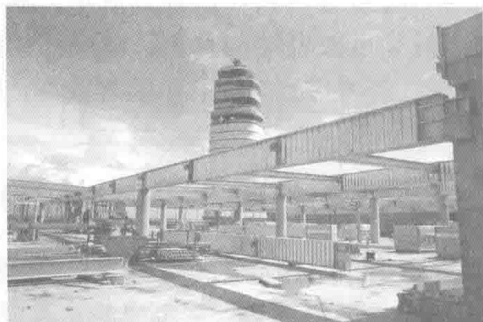
图 1.8 波纹腹板 H 型钢应用于多层框架房屋
