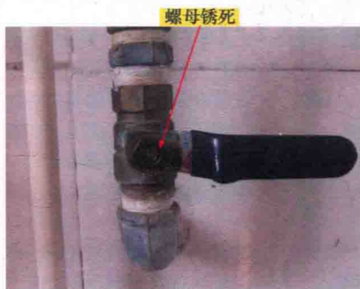
a) 锈死的螺母图例
