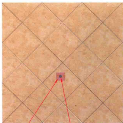
贴封植胶 第一次用6~8mm直径钻头预先打出小孔 然后用所需直径钻头进行扩孔 贴封箱胶
