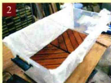
2 将湿毛巾挂在容器两侧,毛巾下侧压在木地板下。以上工序的目的是为了提高容器中的湿度。
