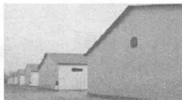
(c) 钢筋混凝土仓库
