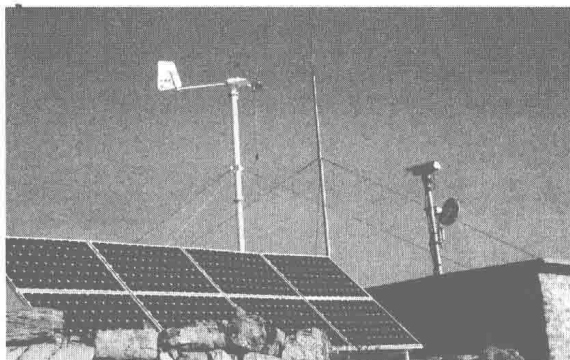
图 1-13 风、光互补型混合发电系统应用实例图
