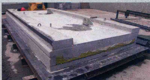
图 C-07 夹心保温预制混凝土外墙 —— 中国最早的在简易厂房生产，运用混凝土模具制作并达到日本精度质量标准的夹心保温 PC 构件
