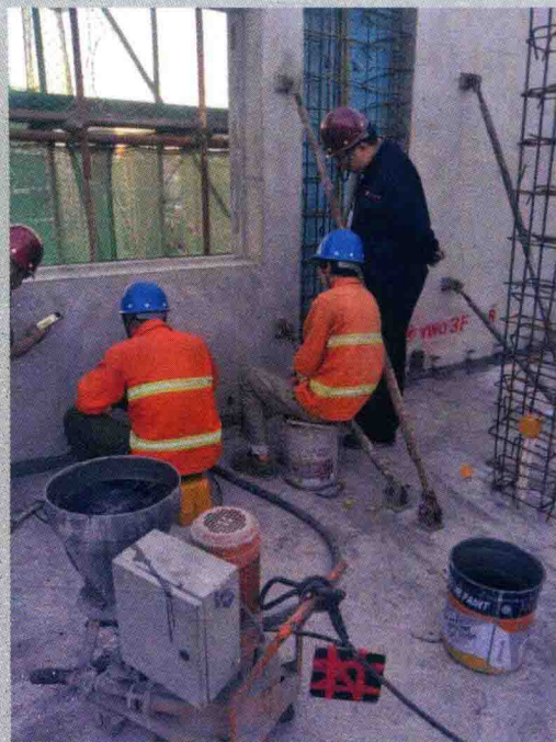
图 C-06 旁站监理 —— 装配式建筑套筒灌浆时需要旁站监理并采集影像资料
