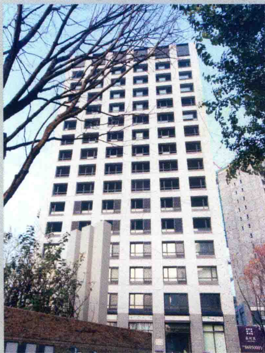
图 C-01 框架结构住宅楼 —— 沈阳万科春河里 17 号楼， 中国最早的高预制率装配式建筑
