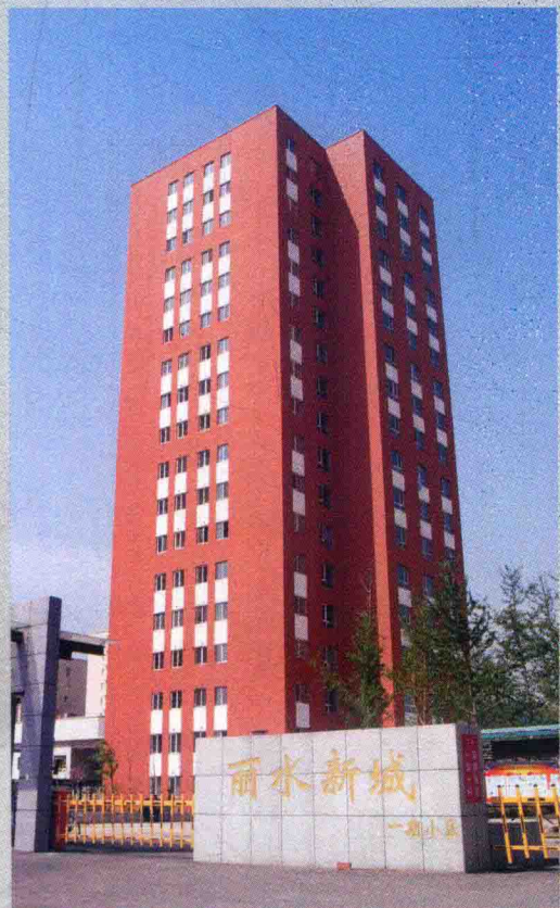
图 C-03 剪力墙结构住宅楼 —— 沈阳丽水新城保障 房，中国最早的一批装配式建筑保障房
