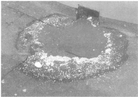
图 1.3-4 倒坡积水（一）
