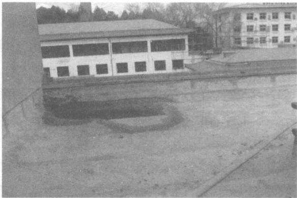
图 1.3-5 倒坡积水（二）
