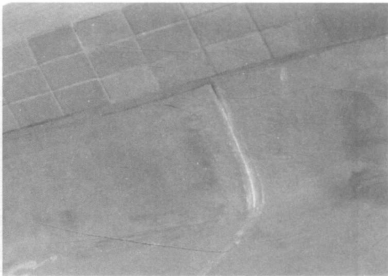
图 1.3-7 卷材防水层收头处张嘴翘边（二）
