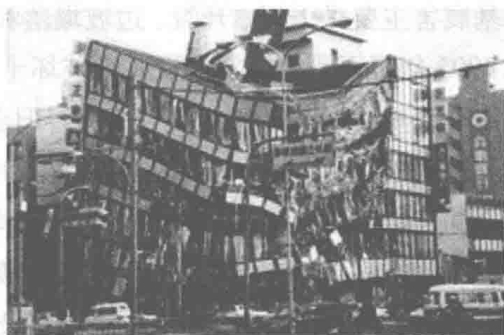
图 1.3.9 日本地震中房屋整体倒塌
