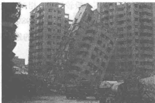
图 1.3.8 汶川地震中房屋倒塌
