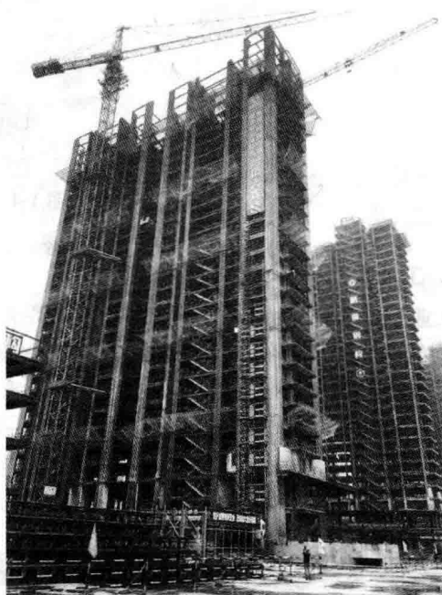
图 1-7 某钢结构住宅在建项目
