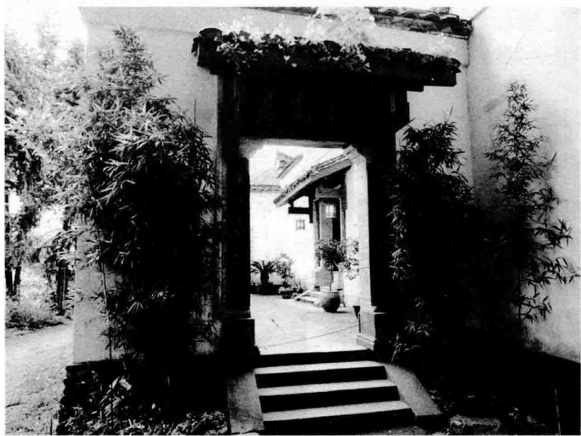
1988 年在朱熹故居遗址新建的紫阳楼
