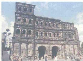
图 1-5 建筑物被腐蚀
