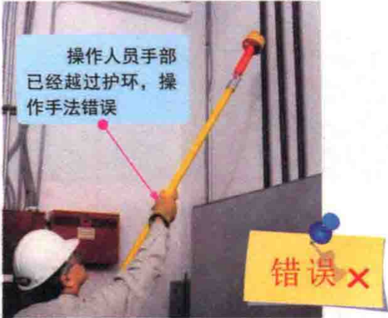
图 1-19 高压非接触式验电器的操作指导
