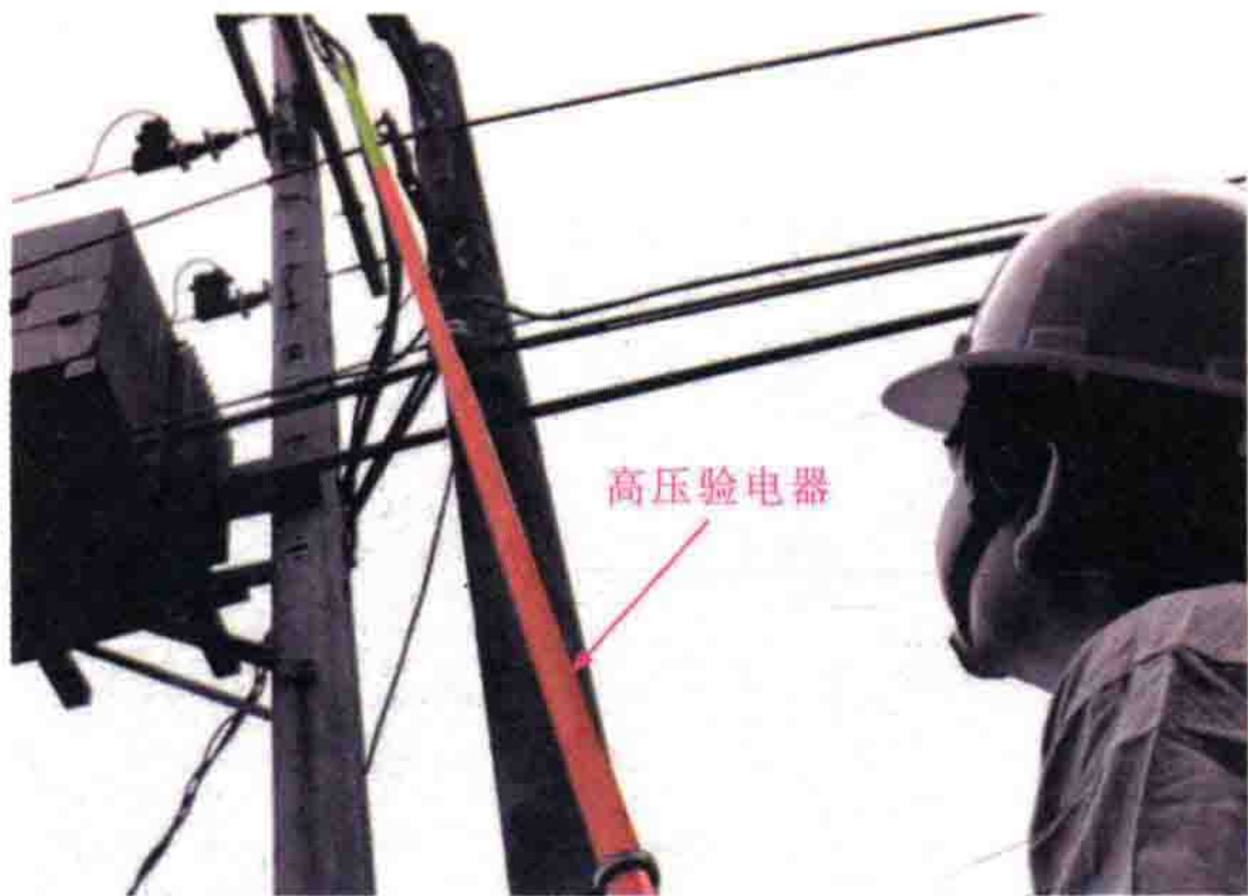
图 1-16 高压验电器验电过程
