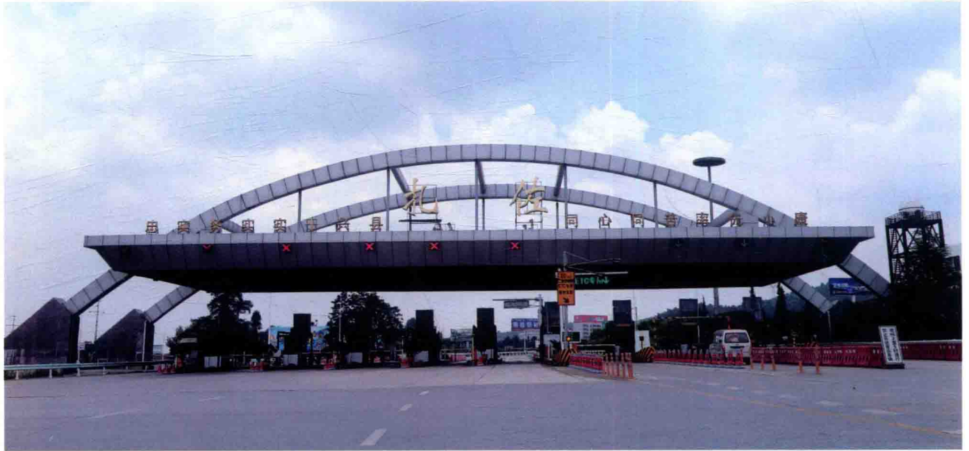
改造升级后的贵遵高速扎佐收费站
