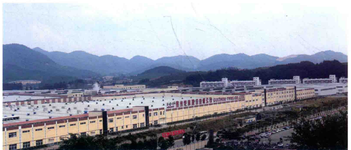
贵州轮胎股份有限公司厂区一角
