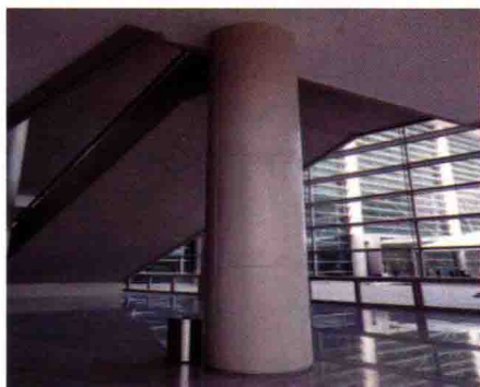
图 16 混凝土结构圆柱施工
