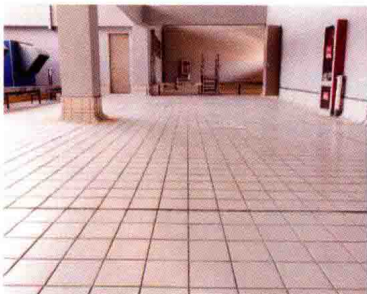
图 9 屋面工程相关图片
