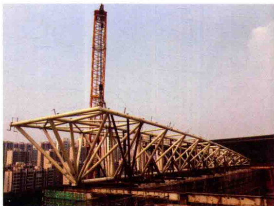
图 17 大悬挑非对称空间立体管桁架整体滑移
