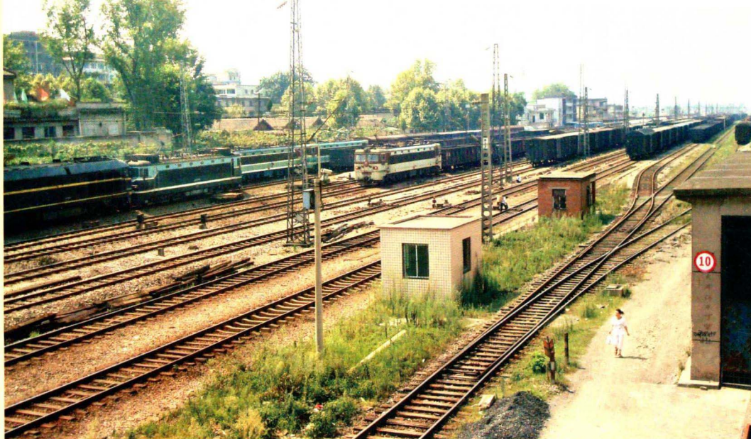
川黔铁路枢纽
