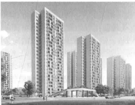
图 1.2-1 北京通州某公租房项目 建筑层数为 14~28 层，最大高度为 79.60m 全部住宅楼均采用建筑工业化方式建造
