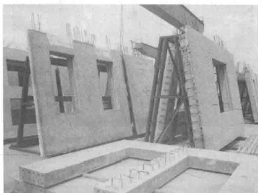
图 1.3-11 预制墙板现场堆放
