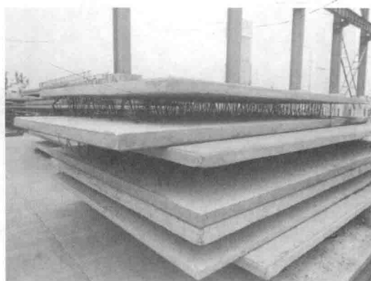
图 1.3-15 双侧叠合墙板现场堆放
