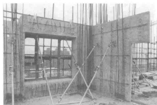
图 1.3-13 单侧叠合墙板的预制部分
