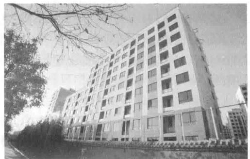
图 1.2-2 北京海淀某公租房项目 建筑层数 9~18 层，最大高度 50.6m 剪力墙、楼板均采用建筑工业化方式建造
