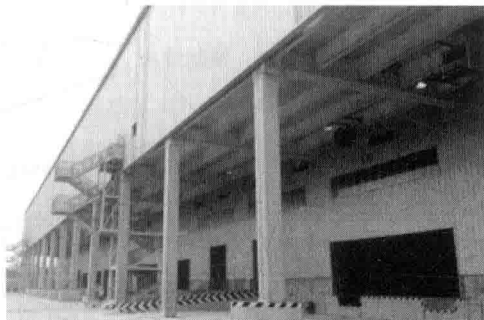
图 1.3-7 装配式混凝土框架结构 (施工完成后)
