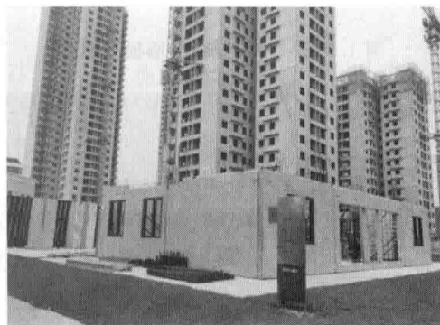
图 1.3-9 装配式剪力墙结构 (预制外墙板施工完成)
