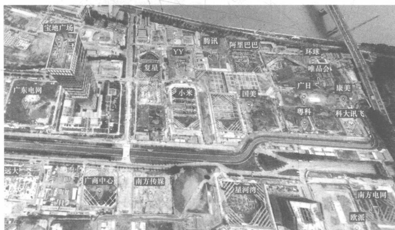
图 1-1 琶洲电商区基坑群
