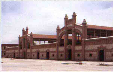
图7 马塔德罗马德里艺术中心, 西班牙 7. Matadero Madrid, Spain
