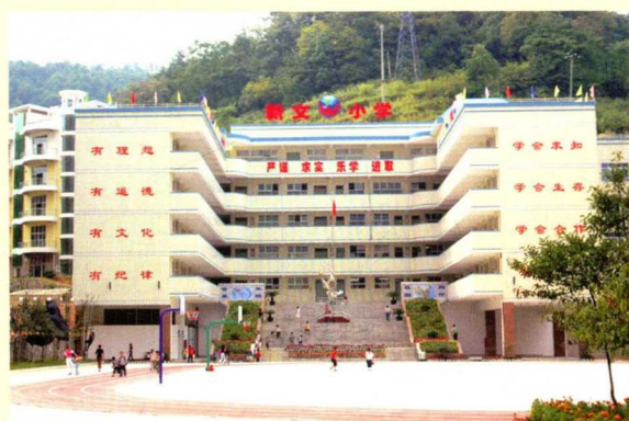
新文小学（整体置换后）
