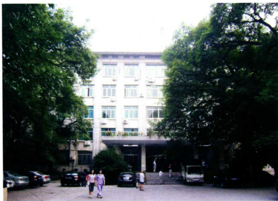
搬迁前的市政府办公楼
