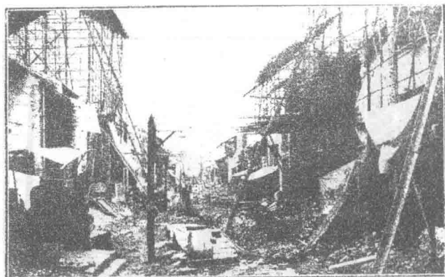
圖路遠靖之中期卸拆
