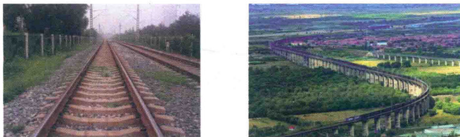
图 1.1 铁路轨道和铁路运输
