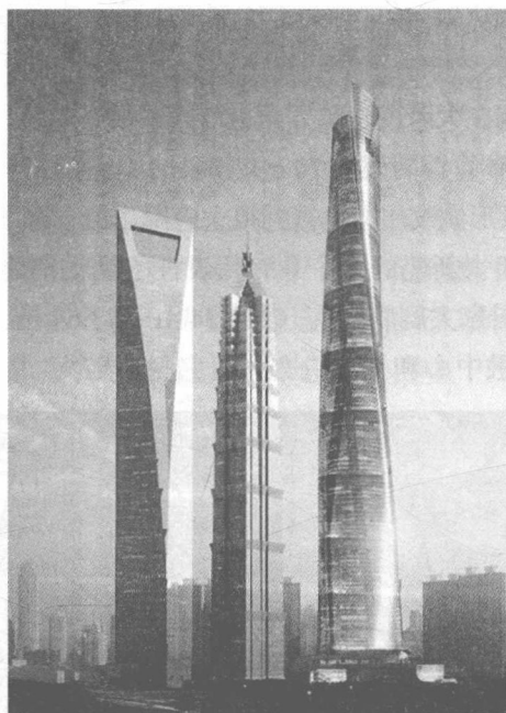
图 1-3 上海中心大厦、上海金茂大厦和上海环球金融中心
