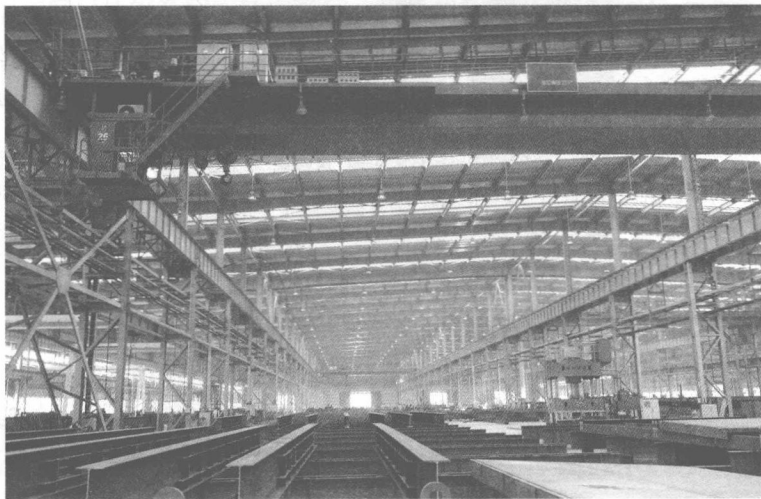
图1-1 上海宝钢钢结构生产车间
