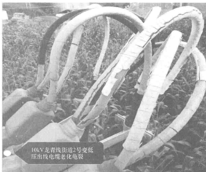
图 1-1-5 电缆老化
