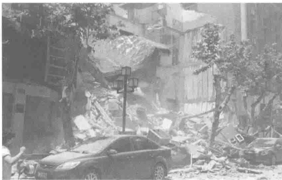
图 1.3-7 浙江杭州某楼全部坍塌
