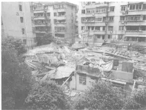
图 1.3-8 浙江某住宅整体坍塌
