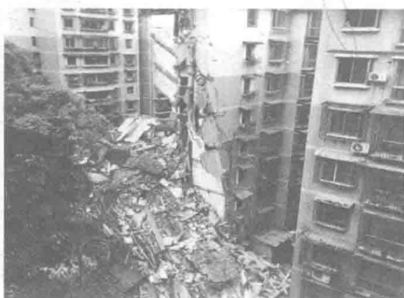
图 1.3-3 贵州某住宅楼局部倒塌
