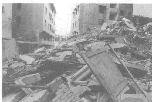
图 1.3-4 贵州某居民楼全部倒塌
