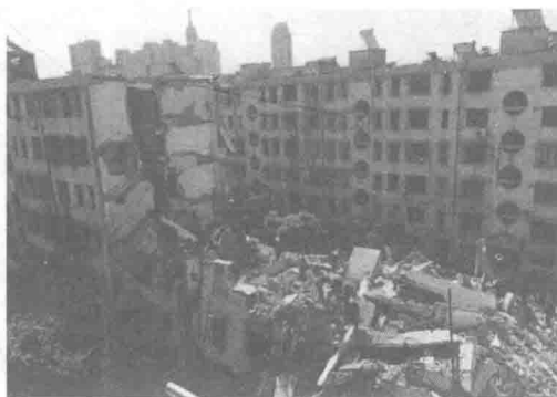
图 1.3-1 浙江某居民楼部分倒塌
