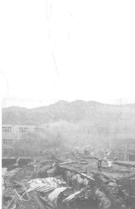
图 1.3-6 浙江某厂房坍塌
