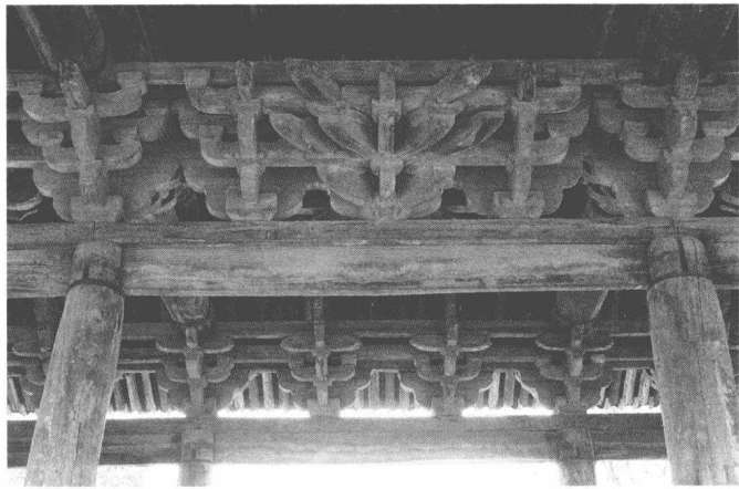
图3 “连拱交隐”产生的补间铺作三朵（图片来源：作者自摄）
