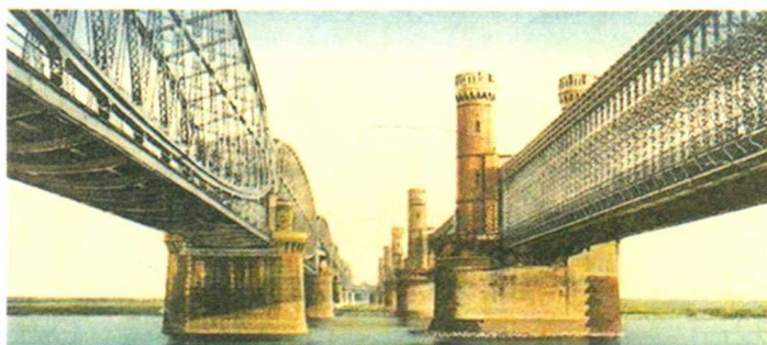
a) 1857年建成格构式桁梁(右), 1891年建成透镜式桁梁(左)
