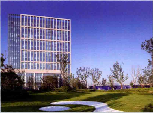
苏州轨道交通 2 号线工程太平车辆段
