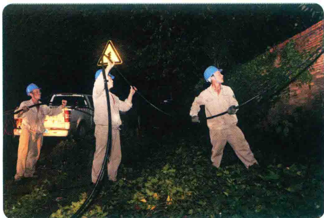
9月29日，国网福建电力抢修因台风“杜鹃”受损的线路。
