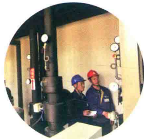
国网山东电力推动燃煤锅炉电能替代改造项目。
