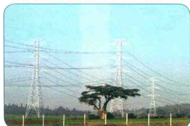
12月22日，公司规模最大的海外总承包工程——埃塞俄比亚500kV国家骨干网输变电工程竣工。
