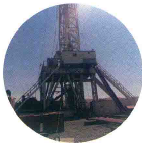
国网新疆电力石油电钻机实现以电代油。
