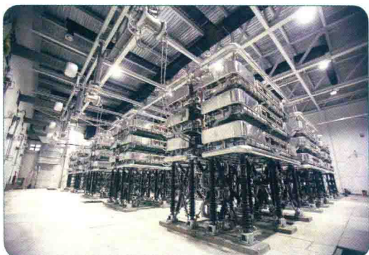
世界上电压等级最高、输送容量最大的±320kV/1000MW柔性直流换流阀。
