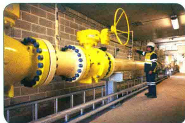
国网澳洲资产公司工人正在检查输气管道。
