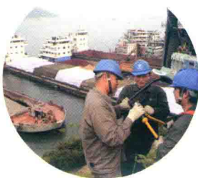
国网湖北电力三峡库区首个岸电试点工程——以电代油项目送电成功。
