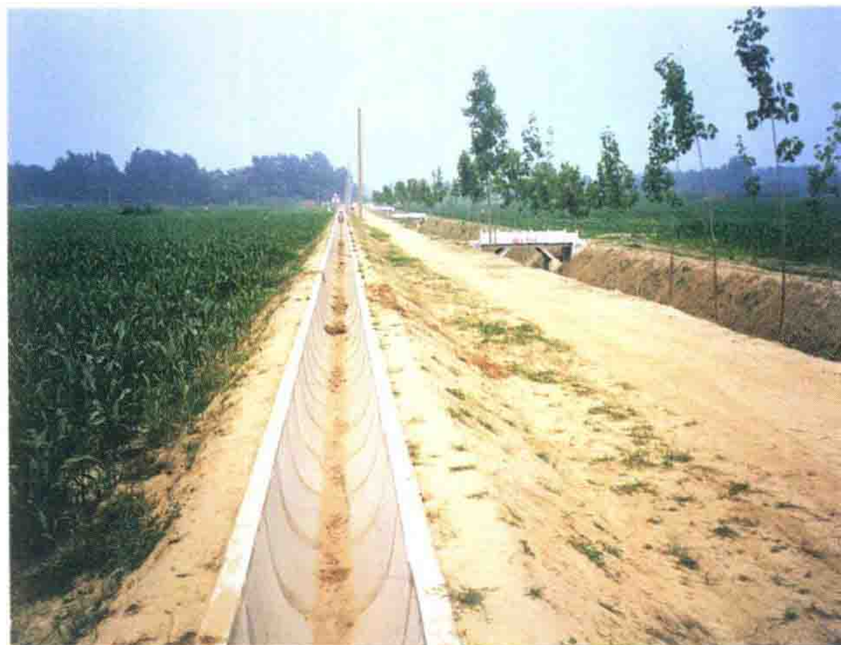
U 型防渗渠道
