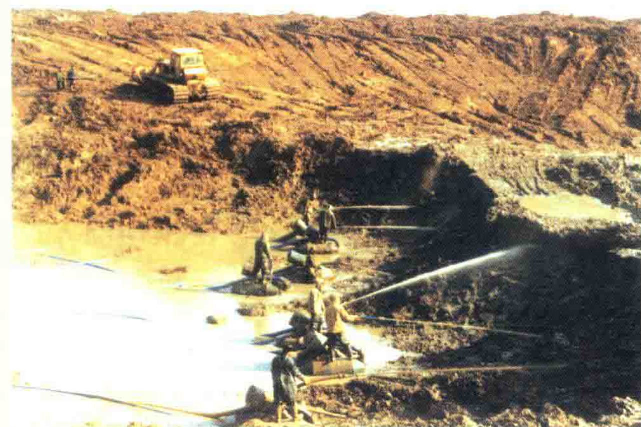
1990 年水力冲土机械化施工开挖大沙河
