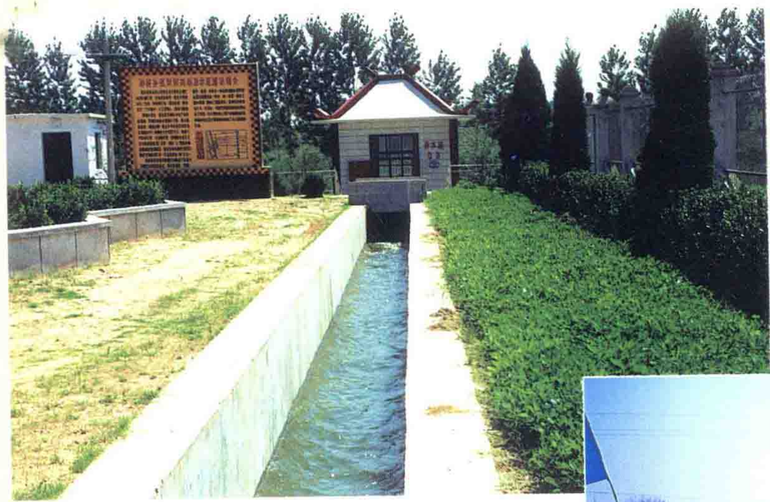
小型机电灌溉站
