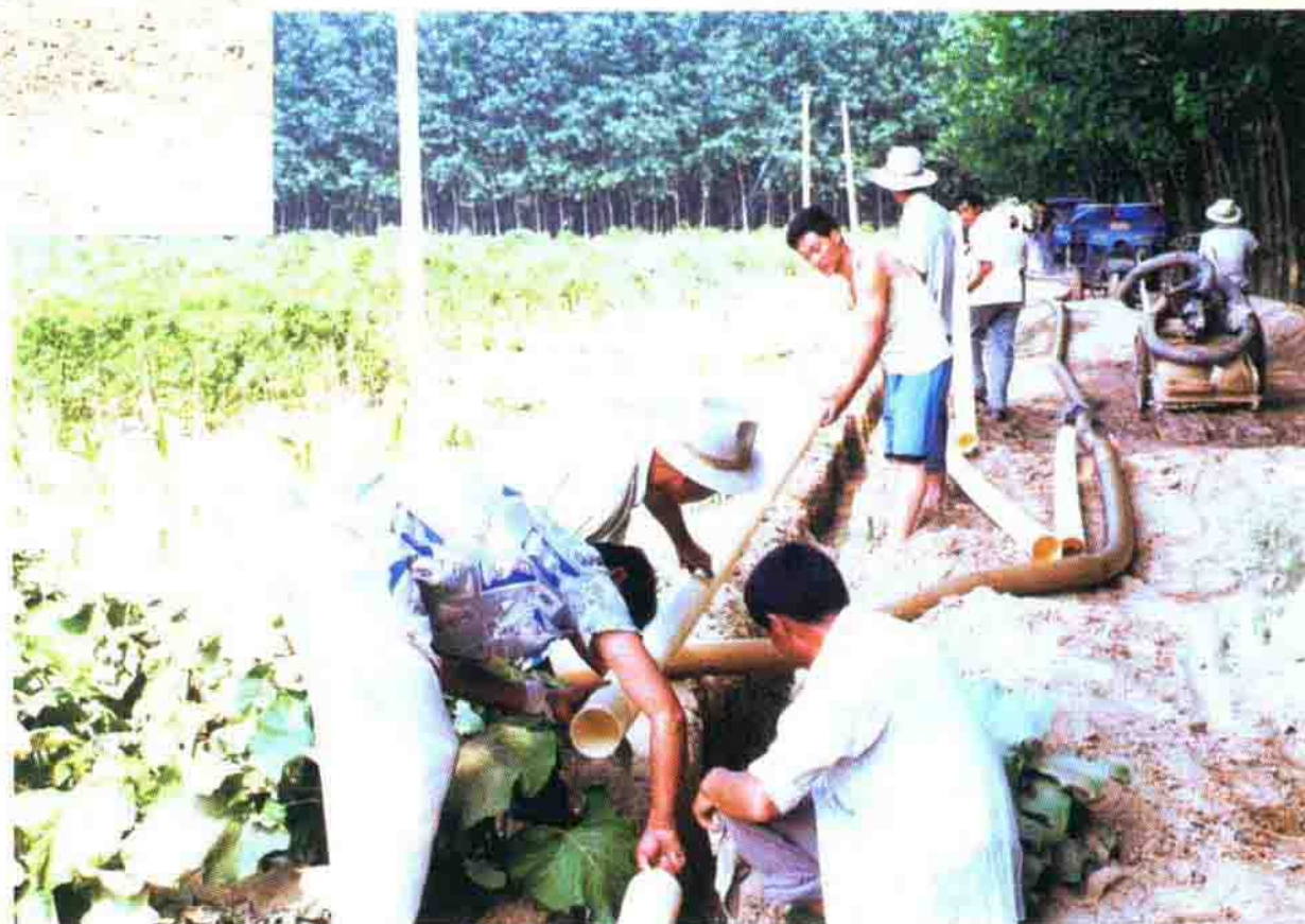
铺设地下输水管道
