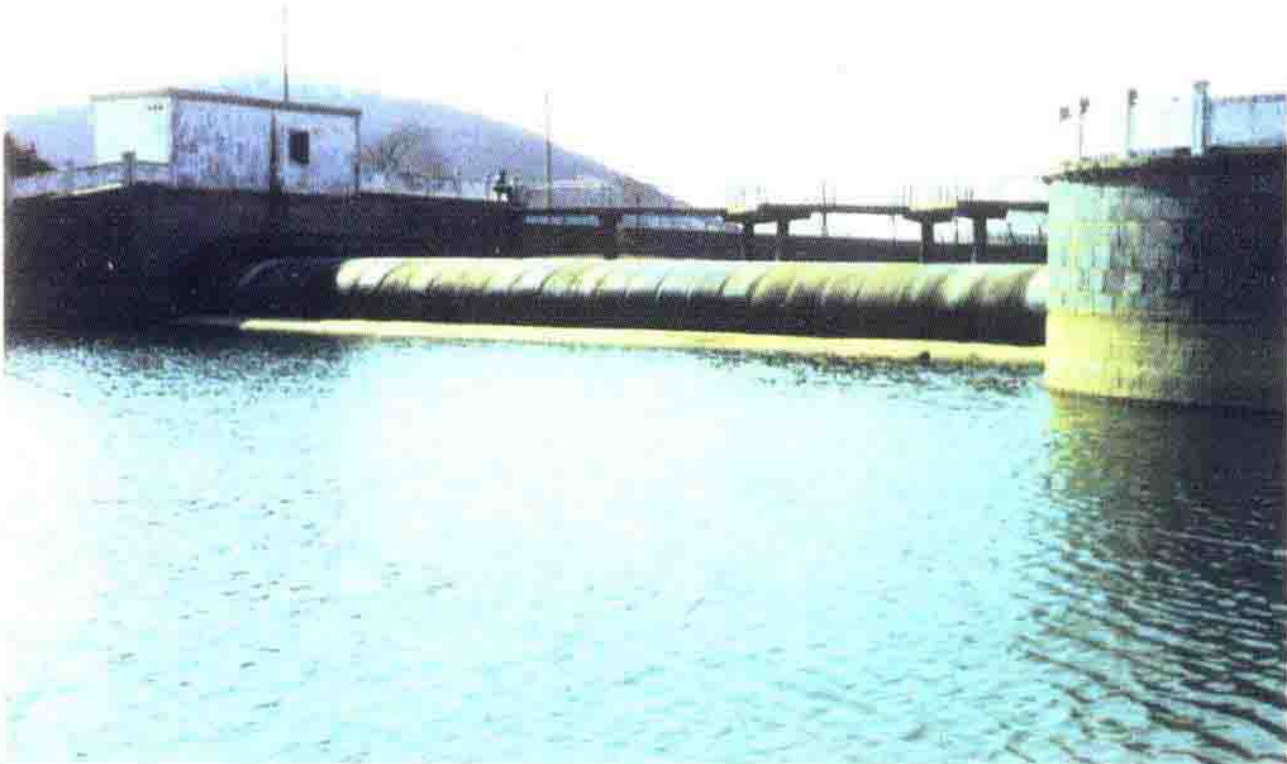
◀ 大沙河夹河橡胶坝
