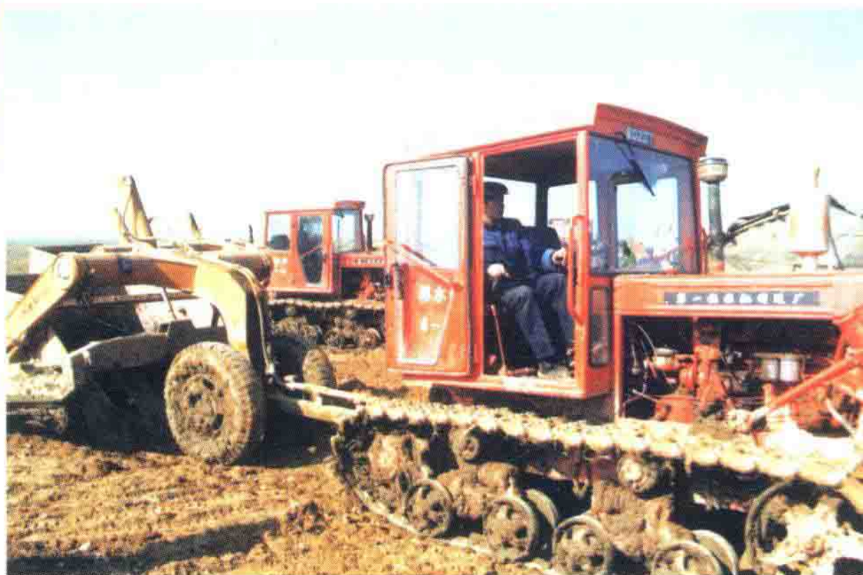
1997 年机械化施工中运河扩大工程
