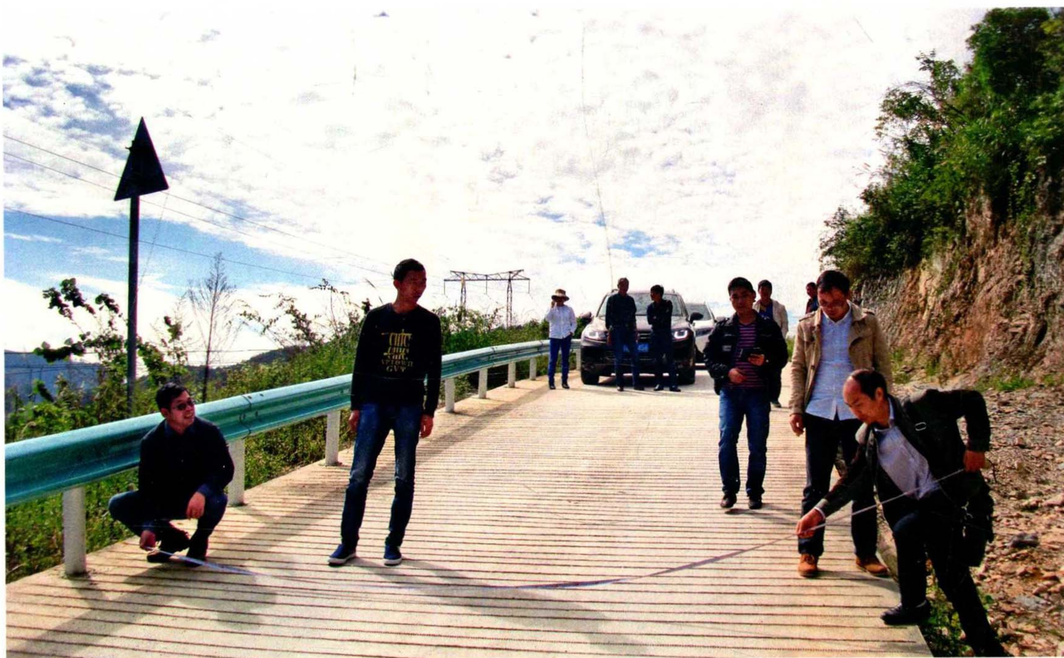
2015年全面开工建设剩余的通村沥青（水泥）路项目，里程合计190.45公里，总投资14857万元，年底基本完工。图为通村油路验收现场
