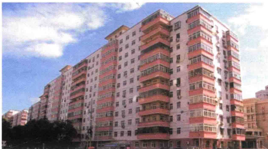
图 1.3 1976 年建成的北京小黄庄 12 层装配式住宅楼
