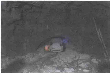
图 1-5 泥石流（冲毁扒渣机）
