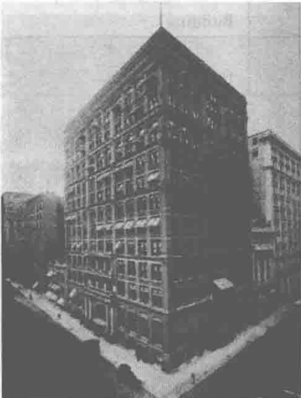
图 1-1 家庭保险大楼 (Home Insurance Building) 世界第一座高层钢铁结构建筑 (1883 年，芝加哥， n=11 层， H=55\text{m} )
