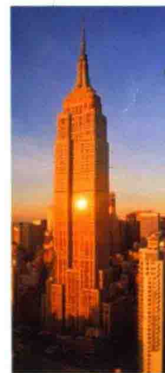
d) Empire State Building H=381\text{m} n=102 框-撑，1931年 用钢量， 206\text{kg/m}^2
