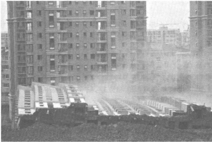
图 0-3 上海“莲花河畔景苑”小区倒塌建筑
