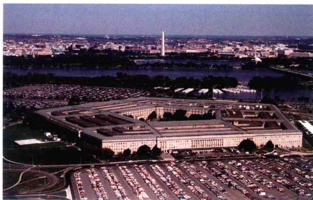
图 1-1-13 美国五角大楼
