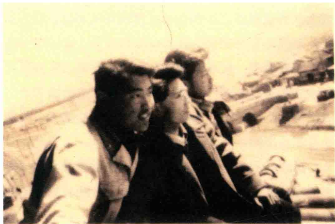
图1 北京内城东南角城楼最高处窗洞外角部屋檐挑檐上
