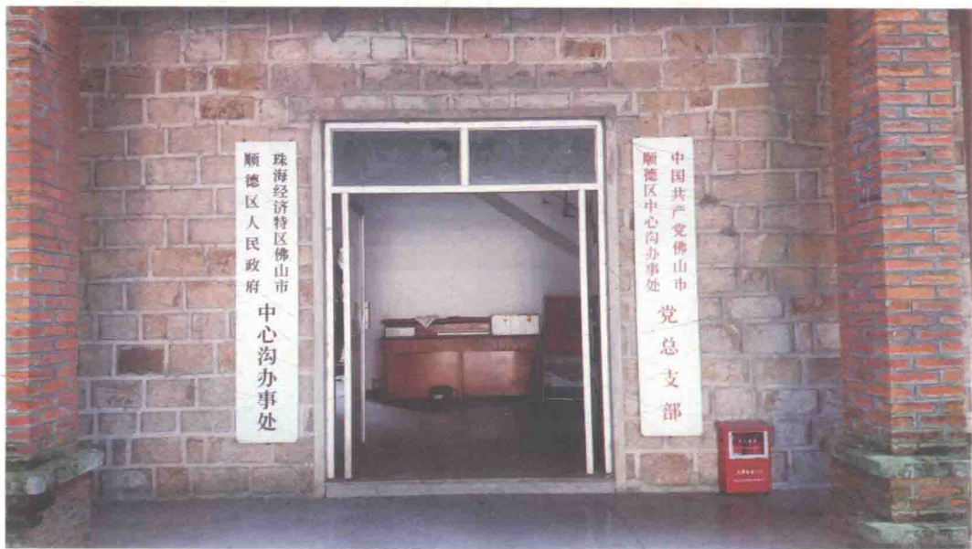
珠海经济特区佛山市顺德区人民政府中心沟办事处旧址办公楼（摄于2016年7月）
