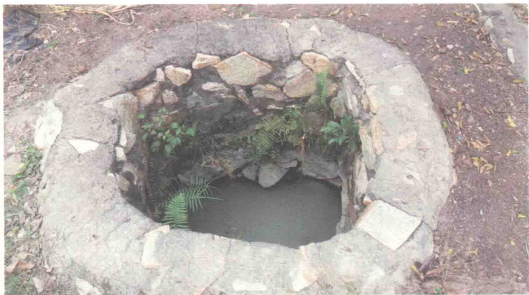
中心沟水井（摄于2016年7月）
