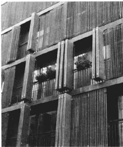
图 11 新型窗结构（Rue Des Suisses 公寓）
