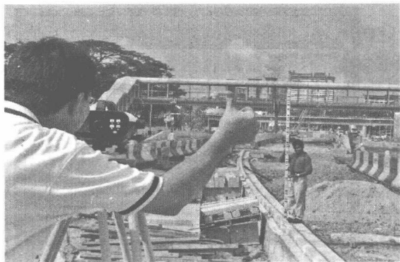
图 1.2.5 工程施工放样
