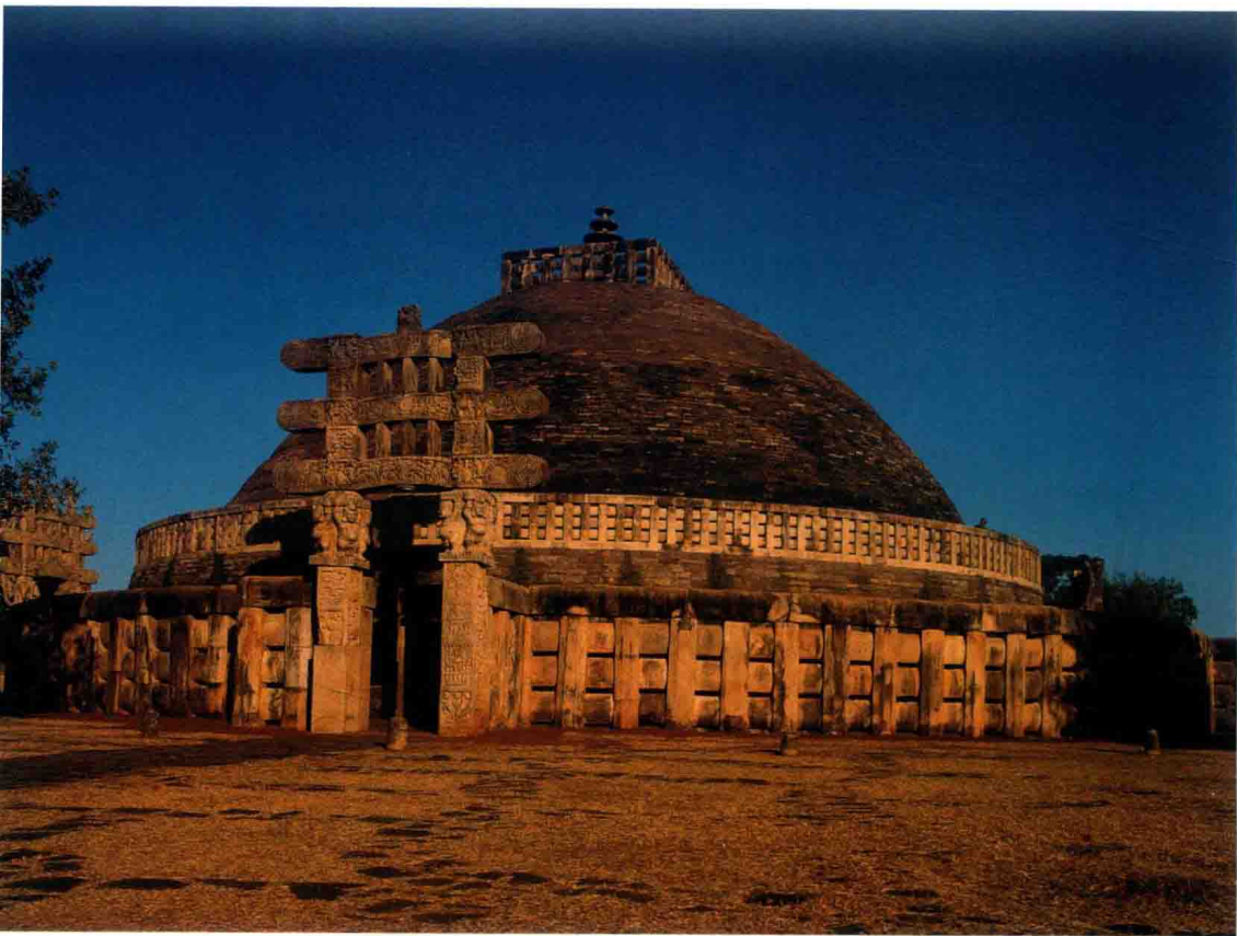
图 1.1 大佛塔（Great Stupa）和西大门（West Gateway）[塔门（Torana）]，印度桑吉。于公元前 3 世纪开始建造，眼前这座佛塔还附带有后来的添加物与增补物。砖与瓦砾最初被覆盖上了色彩艳丽且涂有金色的灰泥装饰物，黄色的石灰岩构成了栏杆和大门，穹顶高 16.4 米。最初由印度统治者阿育王（Ashoka）委托建造（据说他委托建造了 84000 座佛塔），后来，由世俗的佛教团体资助完工。
