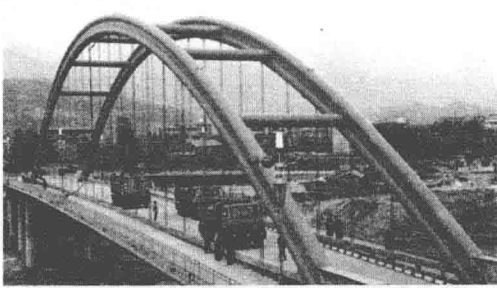
图 1-18 旺苍大桥(国内首座钢管混凝土拱桥)
