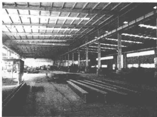
图 1-16 轻钢结构厂房
