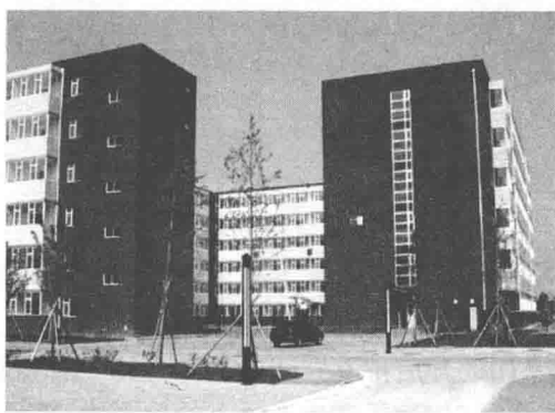
图 1-15 北京某青年公寓钢结构住宅
