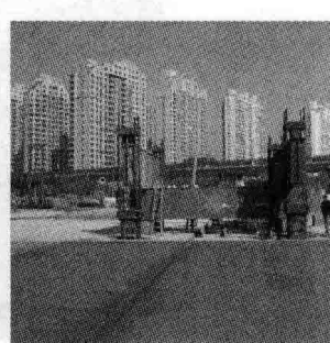
锚桩法抗压静载试验
