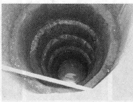
人工挖孔桩灌注前
