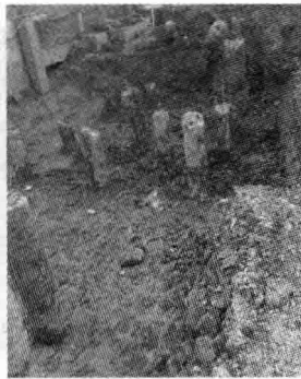
钻孔灌注桩开挖后
