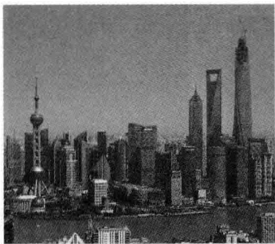
桩基础高层建筑
