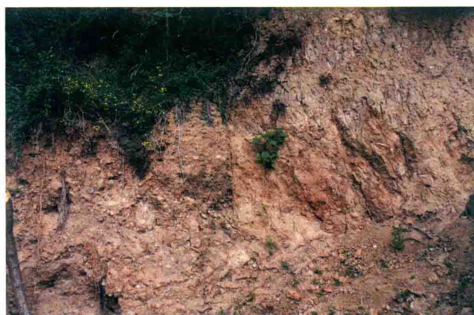
图 1-7 卧龙寺滑坡前缘堆积体
