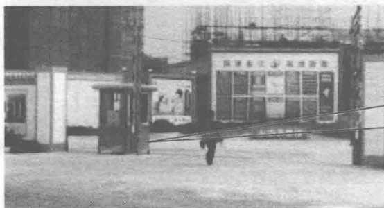
图1-3 施工现场大门设置
