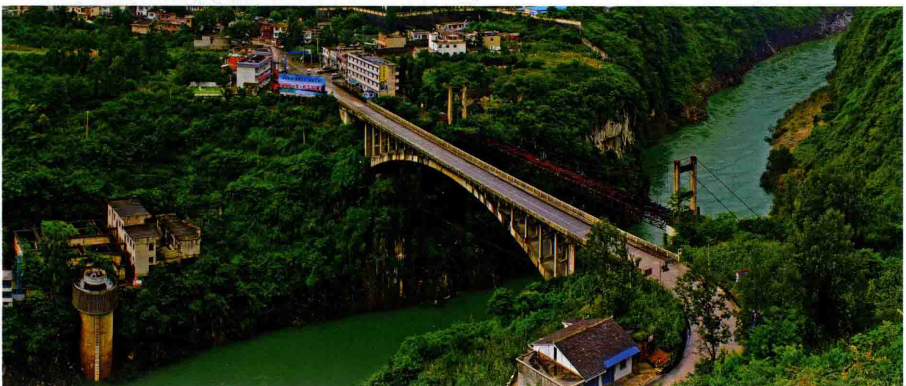
鸭池河大桥（2010年摄）
